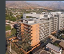
Edificio Río Guadiana 8745 Las Condes
