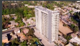
Edificio Vista Walker Martínez La Florida
