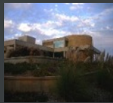
Hospital de Valenar 17.000 m 2
